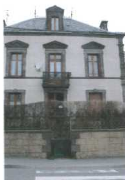
Enduit fin bien réalisé
