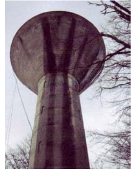
Château d'eau de Sarsoux
